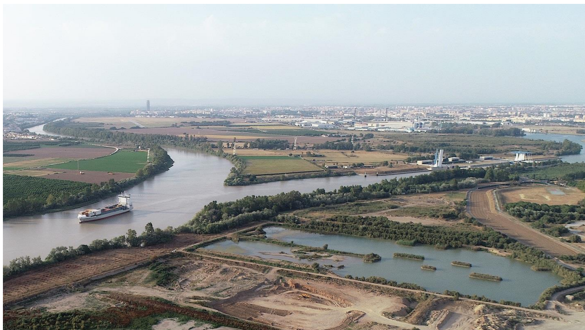
Fotografía aérea de los vaciaderos terrestres del Puerto de Sevilla adaptados con islas para favorecer la cría de aves
