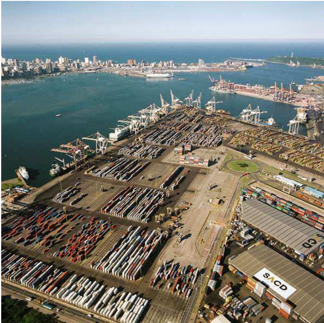
Port de Durban, vue aérienne @Transnet
