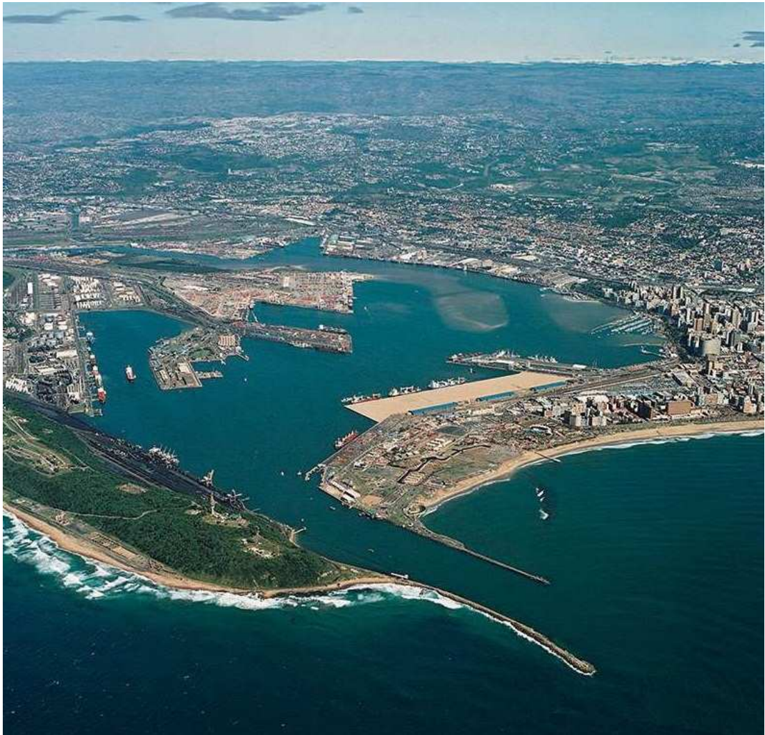
Port de Durban, vue aérienne @Transnet
