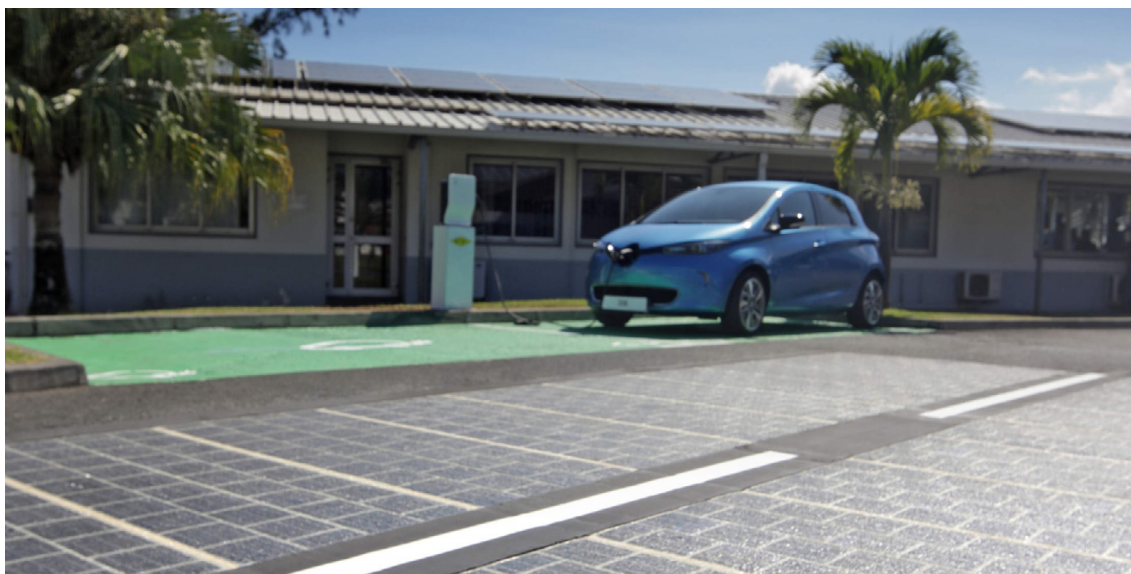
Exemple d'implantation de la route solaire « Wattway » dans la ville de Le Port (La Réunion, France)
