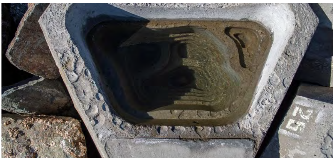
Bassin à marées "Ecoconcrete". (©Port of San Diego)
