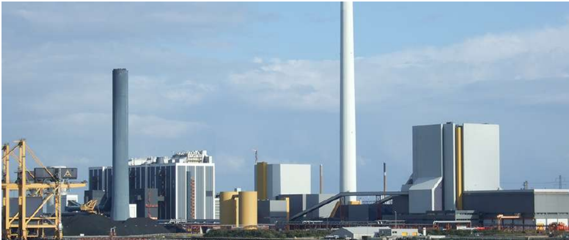
Vue du parc éco-industriel de Kalundborg, Danemark.
